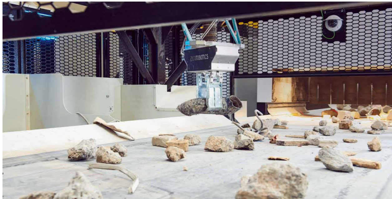
Durch hochwertige Aufbereitung mittels Roboter können mineralische Baustoffe mehrfach im Kreislauf gehalten werden.
