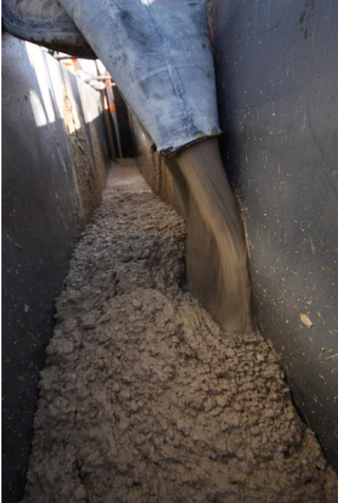
Pouring stabilised earth Maison des associations. Mil'lieux architects. 2014
