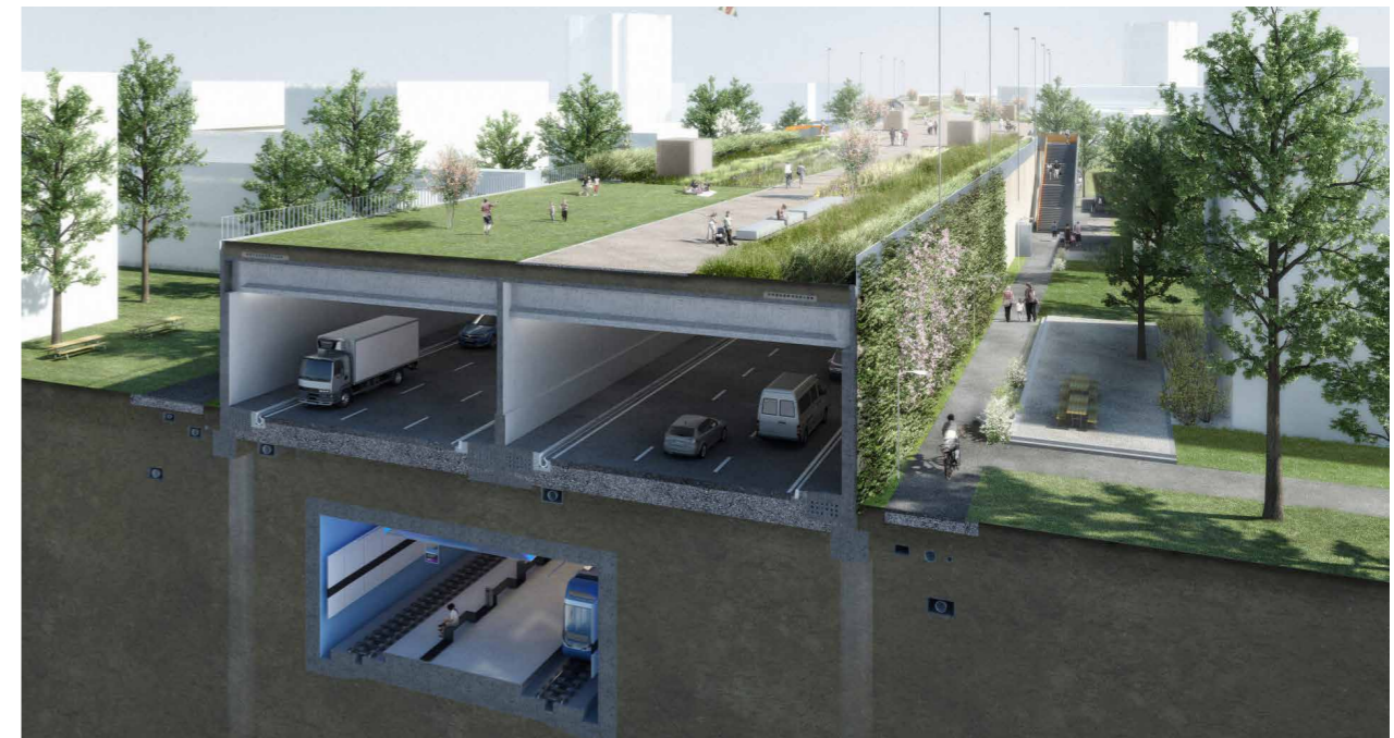
Les tranchées couvertes protègent efficacement du bruit et permettent des utilisations supplémentaires
