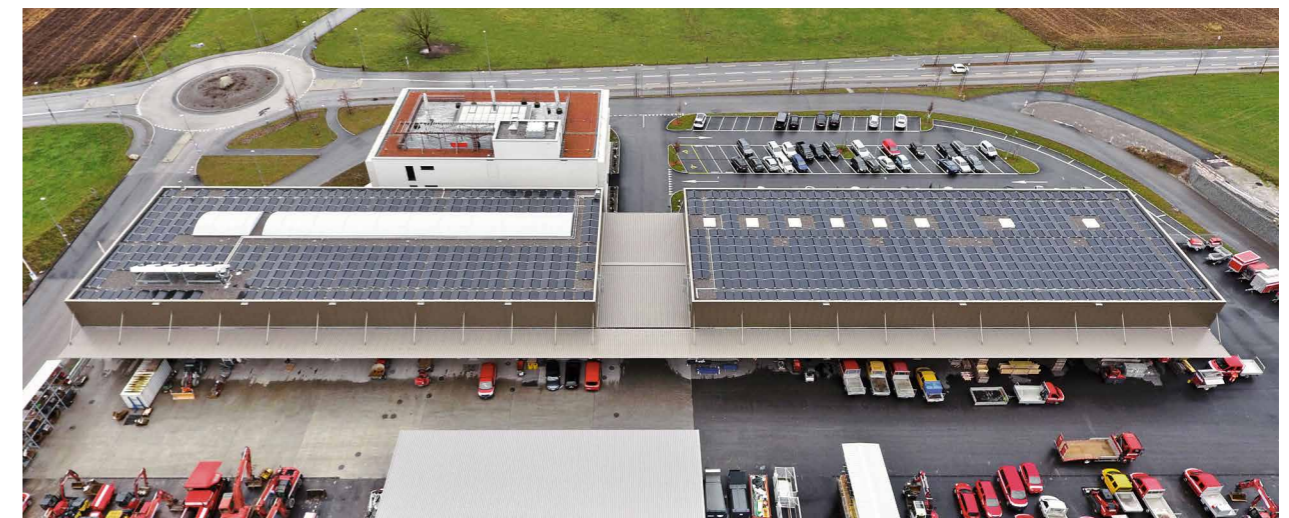
Le boom des installations photovoltaïques: des panneaux solaires sont installés sur les toits de nombreux sites.
