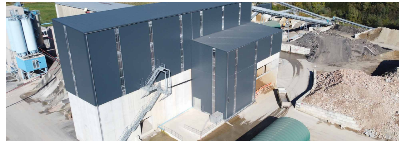
La plus grande installation de lavage des matériaux d'excavation de Suisse est à Gunzgen depuis mai 2021. Le « Baustoffzentrum Olten/Zofingen BOZ » se compose de deux ensembles de bâtiments et mesure jusqu'à 61 mètres de longueur, 25 de largeur et 31 de hauteur. Il peut traiter jusqu'à 370 tonnes de gravier et de matériaux d'excavation par heure.
