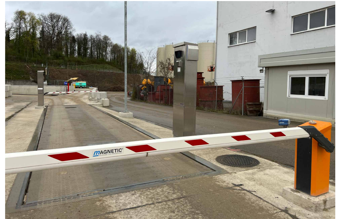
Le contrôle à l'entrée est un élément important de la gestion des matériaux d'excavation.
