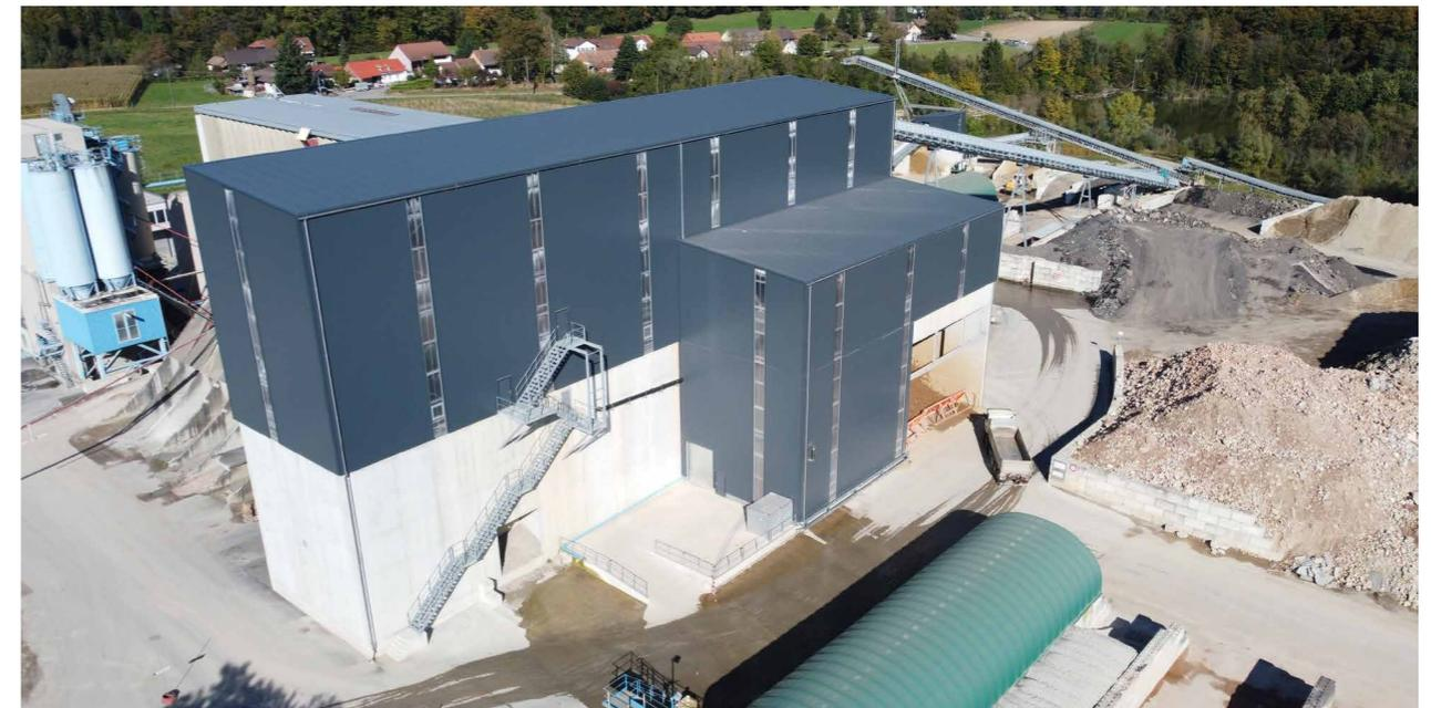
Die grösste Aushubwaschanlage der Schweiz steht seit Mai 2021 in Gunzgen. Die Anlage des Baustoffzentrums Olten/Zofingen (BOZ) besteht aus zwei Gebäudekomplexen und ist maximal 61 Meter lang, 25 Meter breit und bis zu 31 Meter hoch. Sie kann pro Stunde bis zu 370 Tonnen kiesigen Aushub und Kies aufbereiten.
