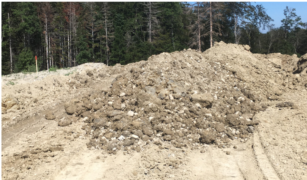
Les matériaux d'excavation propres peuvent être utilisés comme matériau de remblayage dans les gravières.
