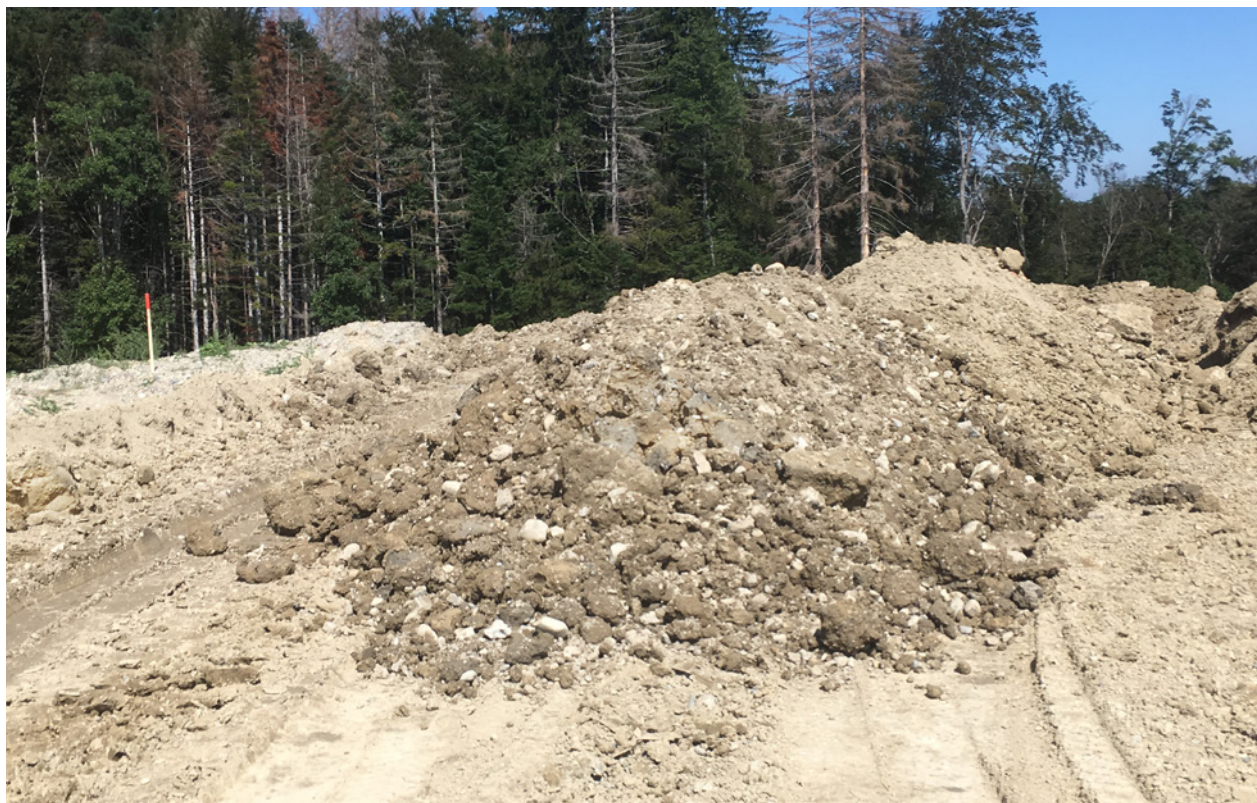
Sauberer Aushub lässt sich als Auffüllmaterial von Kiesgruben verwenden.
