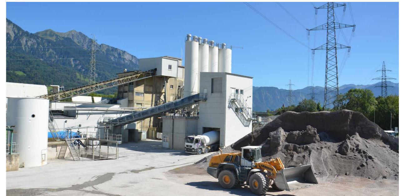
Installation de lavage de terres avec mélangeur de Logbau AG à Rheinau (SG)
