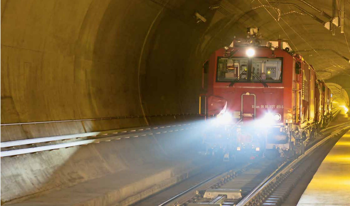
In den letzten Wochen und Monaten wurde der Tunnelbetrieb im Bözberg intensiv getestet.
