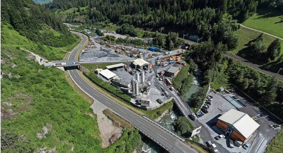
Die Luftaufnahme zeigt den Eingang zur Baustelle des Brenner-Basistunnels.
