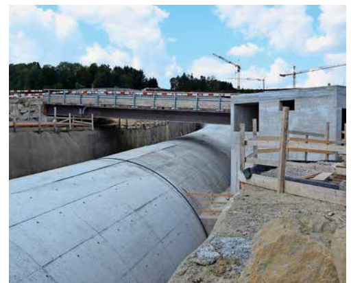
Tagbautunnel Letten, betonierte.
