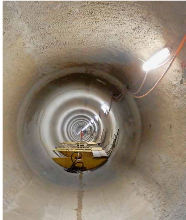
Für die Erweiterung des Fernwärmenetzes in der Stadt Zürich wurde das Microtunneling-Verfahren gewählt.
