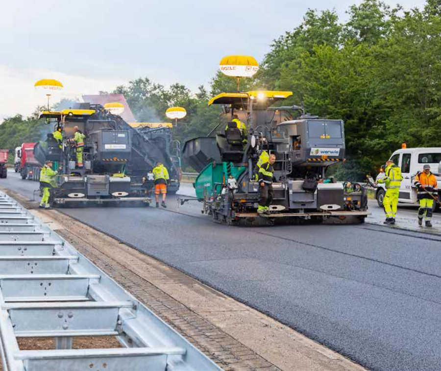
Einsatz von zwei Super 1800-3i Spray-Jet im „Heiss an heiss“-Verfahren.
