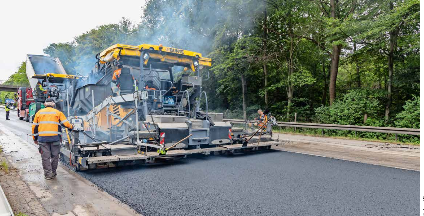
Der Einbau der Binderschicht auf der A 3 erfolgte mit zwei Vögele Fertigern Super 2100-3i, unterstützt von jeweils einem Beschicker MT 3000-2i Offset.
