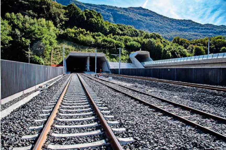
Der Ceneri-Basistunnel bildet den Abschluss der NEAT.
