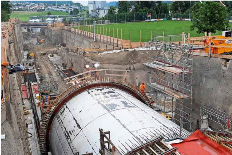
Der Tagbautunnel Letten, Blick Richtung Nord, mit Schalwagen
