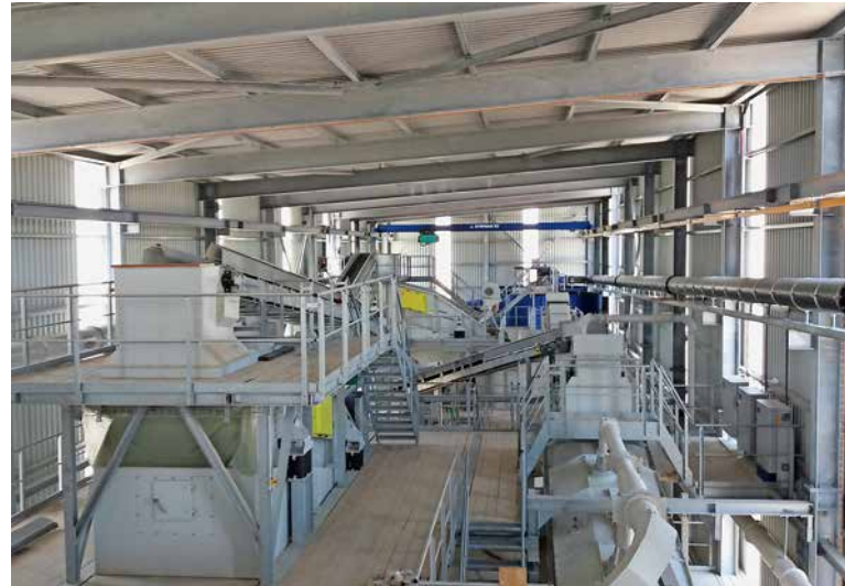
Ein Blick in das innere Leben des Kieswerkes.
