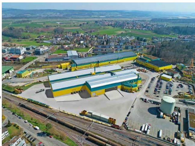
Für die neue Aufbereitungsanlage in Oberglatt werden die bestehenden Industriehallen um 100 m verlängert.
