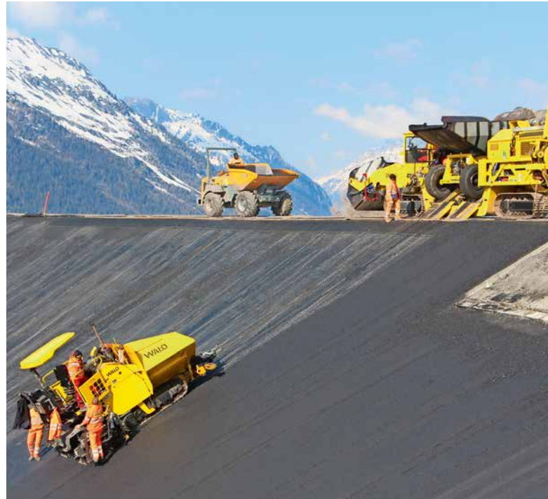
Das Windenportal zieht den Asphalt-Fertiger bei den Belagsarbeiten.
