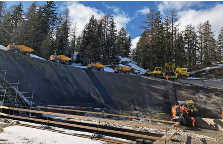
Acht Racos 4000 bringen abgetragenes Material in die Recycling-Anlage.
