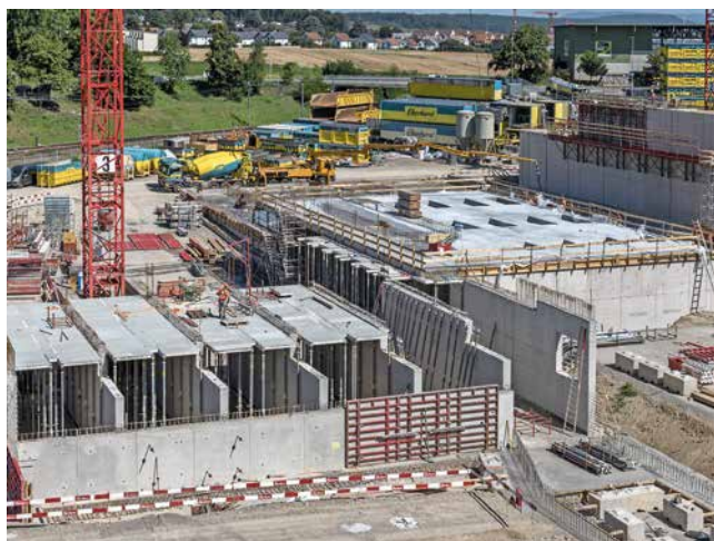
Die Bauarbeiten sind soweit fortgeschritten, dass der Tiefbau zum grössten Teil abgeschlossen ist, der Hochbau steht nun im Vordergrund.
