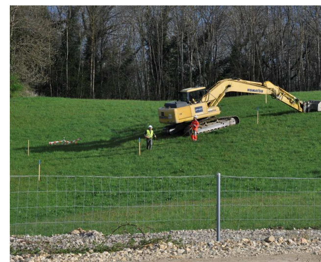
Mise en place de tensiomètres (entourés de rubalise) pour contrôler l'engagement des machines sur le sol (VD)
