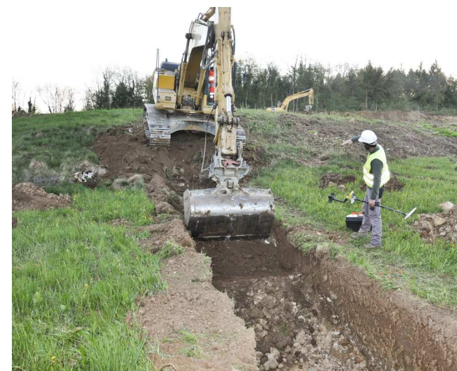
Creusement d'un sondage de diagnostic afin d'observer la stratigraphie et de repérer les vestiges archéologiques (VD)
