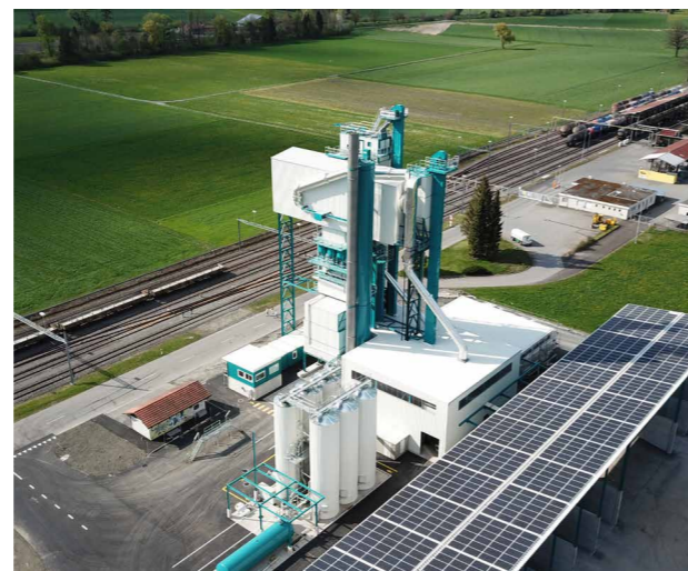
Système de recyclage moderne à contre-courant avec un mélangeur de haute technologie de recyclage à Sennwald (SG).
