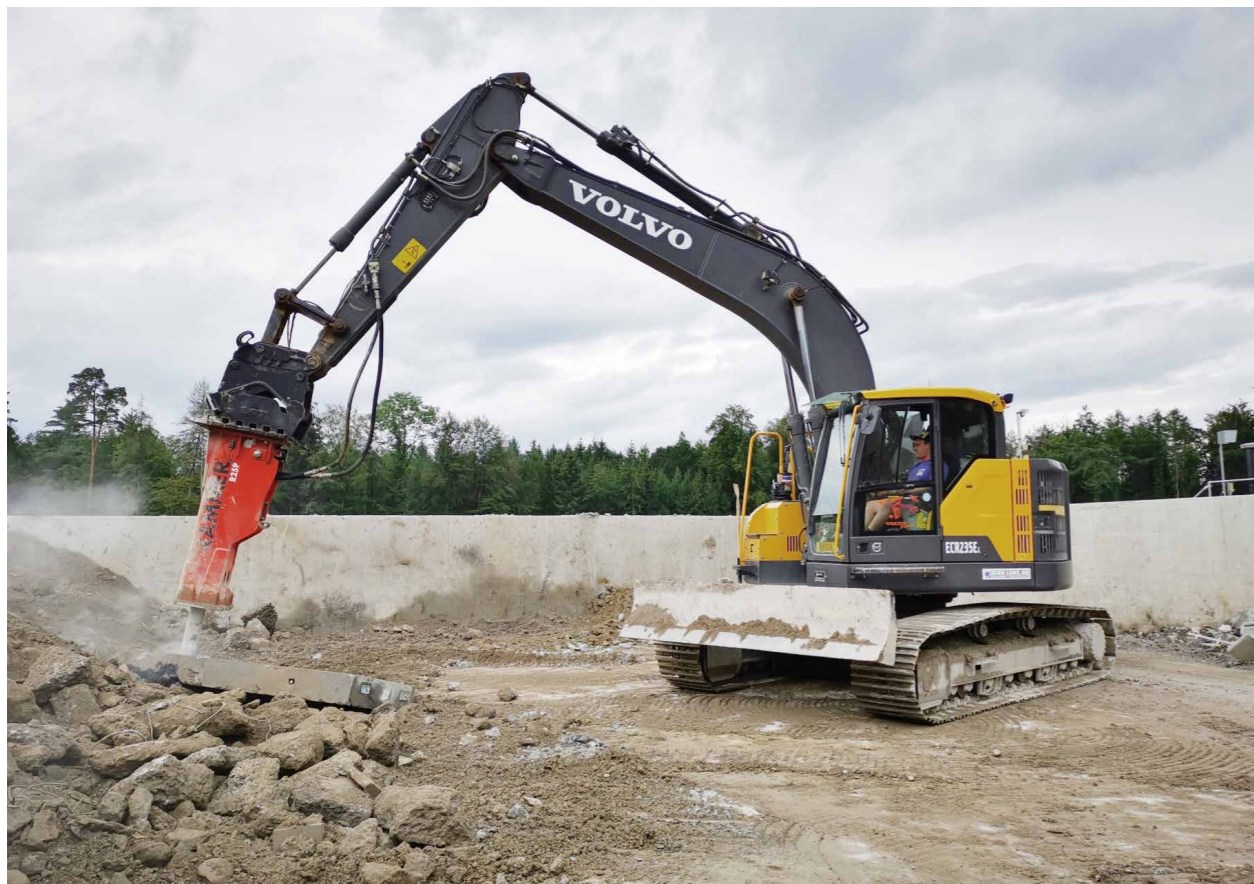
Marcel Bertschi lors du concassage de matériaux de démolition.
