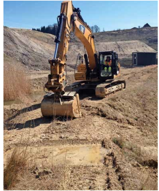
Mit dem Bagger werden Gewässer gebaut.
