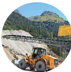
Das Gebiet Las Piazzettas bei Preda hat sich als der umwelttechnisch zweckmässige Standort für die Endlagerung des Tunnelausbruchs erwiesen.
