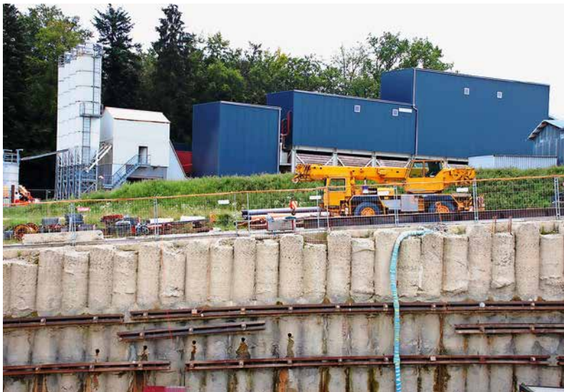
Das in unmittelbarer Nähe gelegene Kiesaufbereitungs- und Betonwerk im Jenkenacher konnte während der Rohbauphase so gut wie den ganzen Kies- und Betonbedarf der Baustelle decken.
