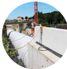
Dem bergmännisch vortriebenen Tunnel ist auf der Ostseite eine 170 m lange Tagbauröhre vorgelagert, die eingedeckt und begrünt wird.
