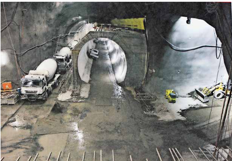
Eindruckliches Bild von der Rohbau- und Betonierphase im Ceneri-Basistunnel, welches die Haus in Haus genannte Röhrenkonstruktion in der Caverna Operativa zeigt.
