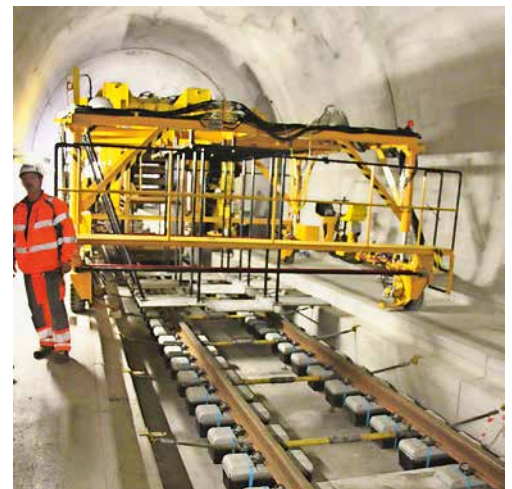
Als Fahrbahnsystem kommt das bewährte Low Vibration Track (LVT) zum Einsatz, bei dem die Betoneinzelblöcke in eine Betonplatte eingegossen und von einem Nachbehandlungswagen aus von Hand abtalochiert werden.
