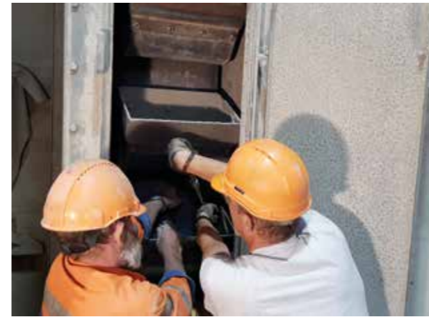
Maintenance de l'élévateur à godets par Patrick Gasser et le mécanicien Ruedi Keusch
