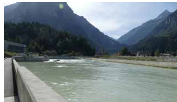
Bassin de décantation de la KWO: l'Aar est bridée.
