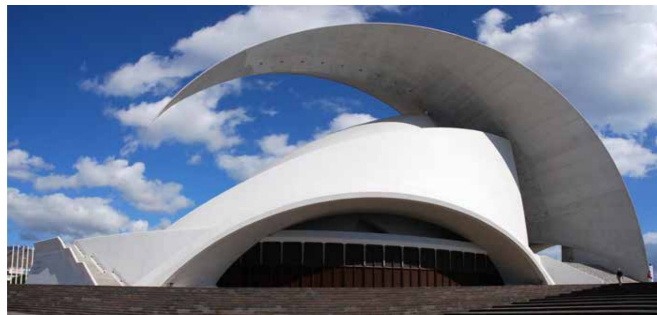
L'auditorium Santa Cruz à Ténériffe avec ses ailes courbes impressionnantes en béton a été conçu par l'architecte renommé Santiago Calatrava.
