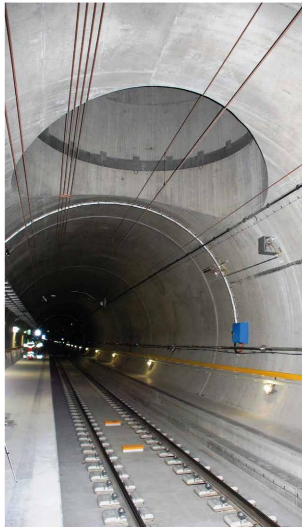
Die 57 km langen Tunnelröhren sind für eine Gebrauchsdauer von 100 Jahren ausgelegt.
