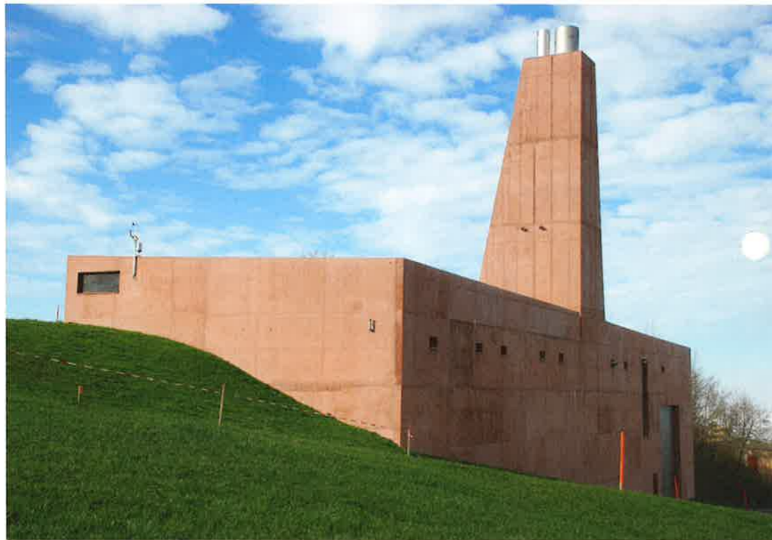
Farbiger Sichtbetonbau: Holzheizzentrale von Menzingen ZG.
