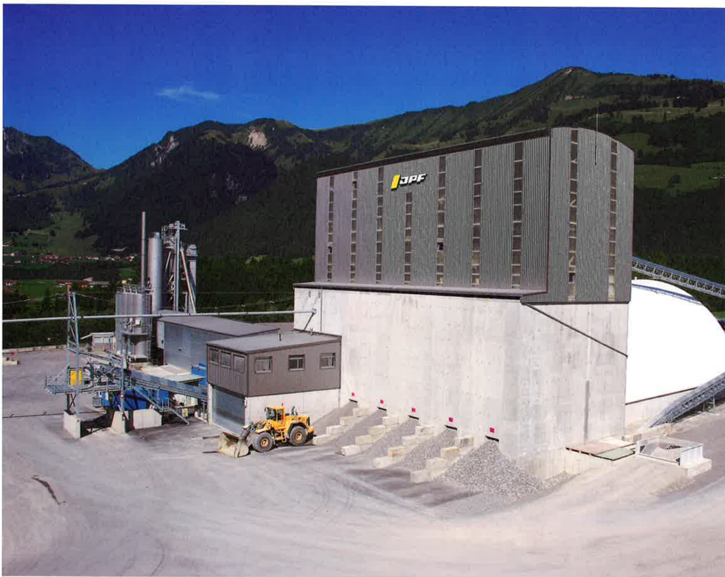
Sieht nicht nur modern aus, sondern genügt auch den höchsten technischen Ansprüchen: Kieswerk in Grandvillard.
