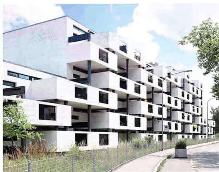
Nicht nur schön anzuschauen, sondern auch sinnvoll: nach den Qualitätsrichtlinien von Greenbuilding errichtetes Gebäude.
