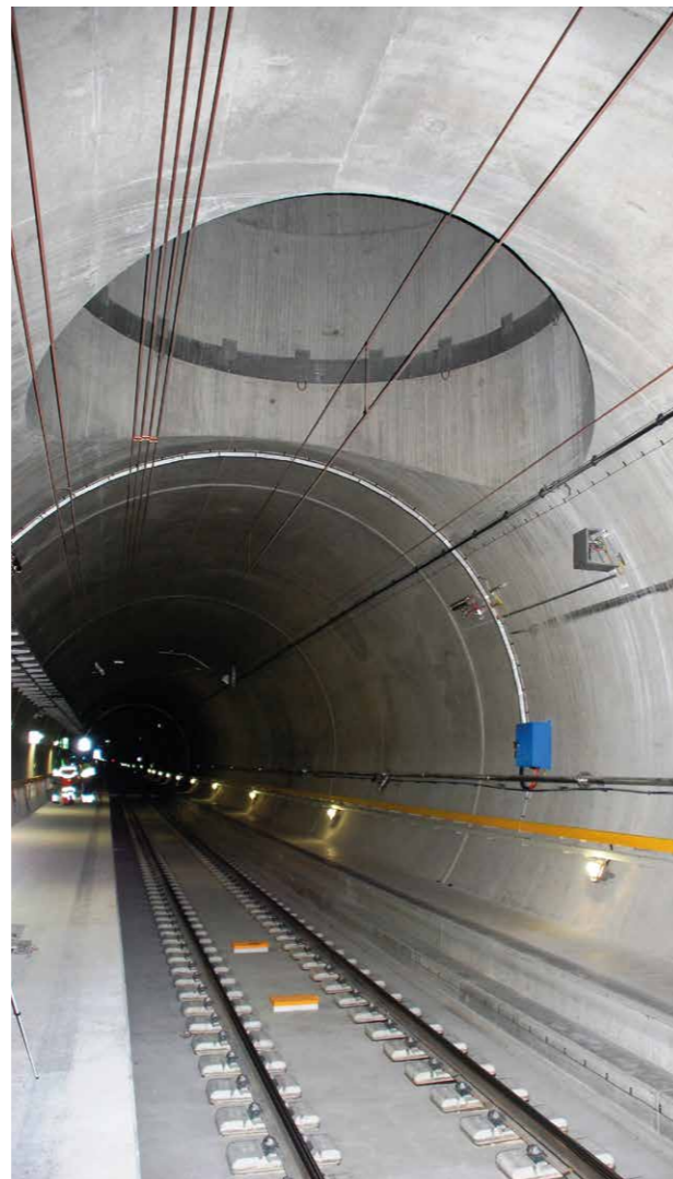
D'une longueur de 57 km, les tubes du tunnel sont conçus pour une durée d'utilisation de 100 ans.
