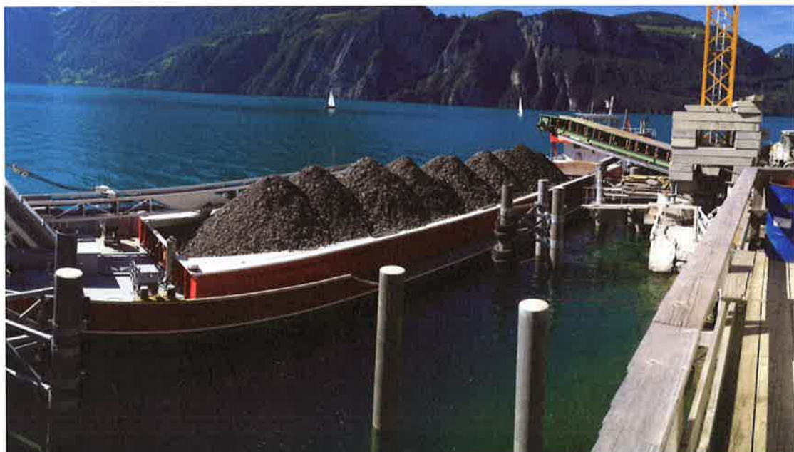
Quai d'accostage avec esplanade au portail de la galerie d'accès. Vue Ouest.
