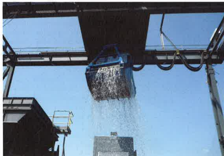
Des dragueurs sont utilisés pour l'extraction.
