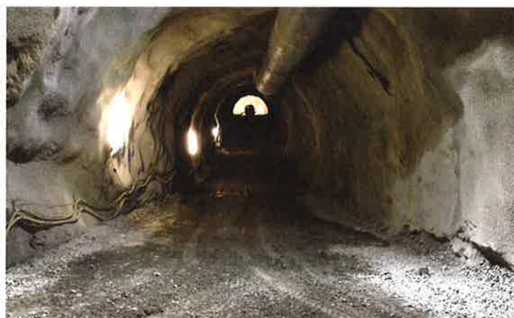
Galerie d'accès au niveau d'exploitation inférieur, peu avant le croisement avec le tunnel CFF de l'Ölberg.
