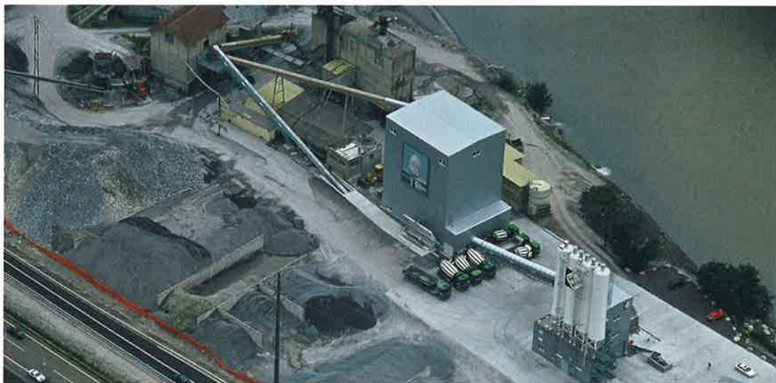
La centrale à béton de la firme Gravier et Béton Tardis SA à Maienfeld.
