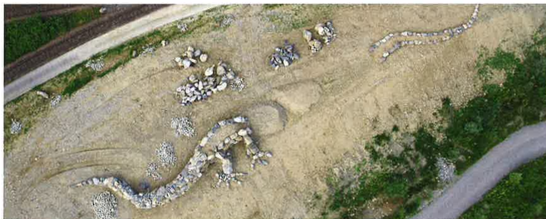
Prise de vue aérienne durant la construction.
