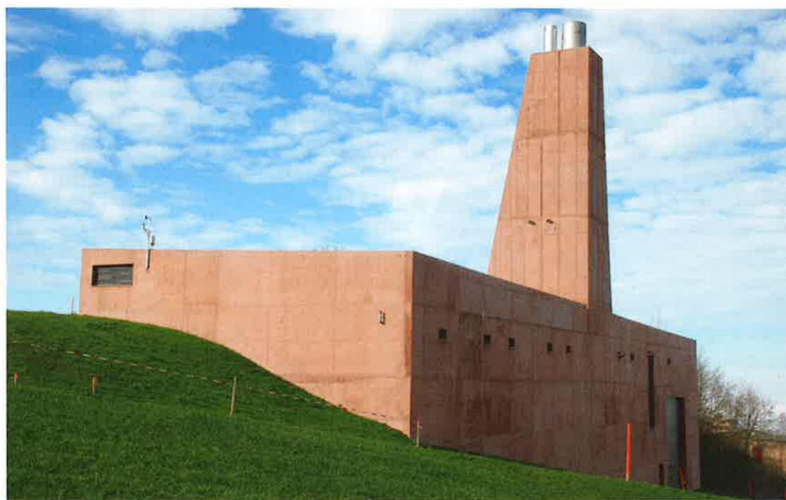
Construction en béton apparent coloré : centrale de chauffage au bois de Mentzingen ZG.
