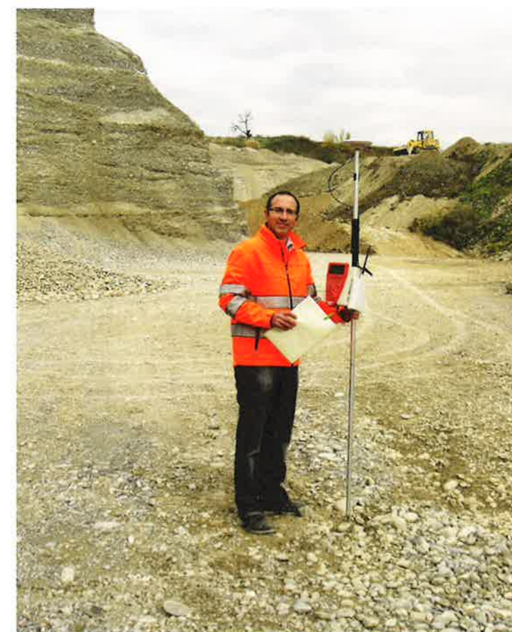
L'inspecteur autonome de l'Association contrôle la qualité des matériaux de remblayage et la profondeur d'extraction.
