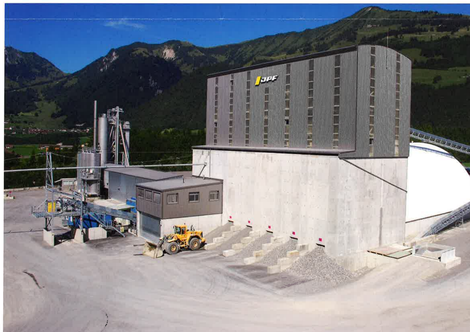
Entreprise de gravière de Grandvillard: non seulement moderne, mais répondant aux plus hautes exigences de la technique.
